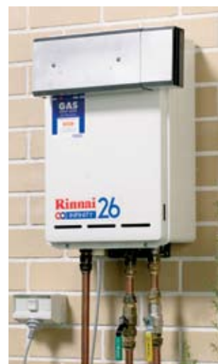
Flue Diverter
